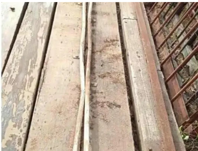
2 vigas de madera dura 1
