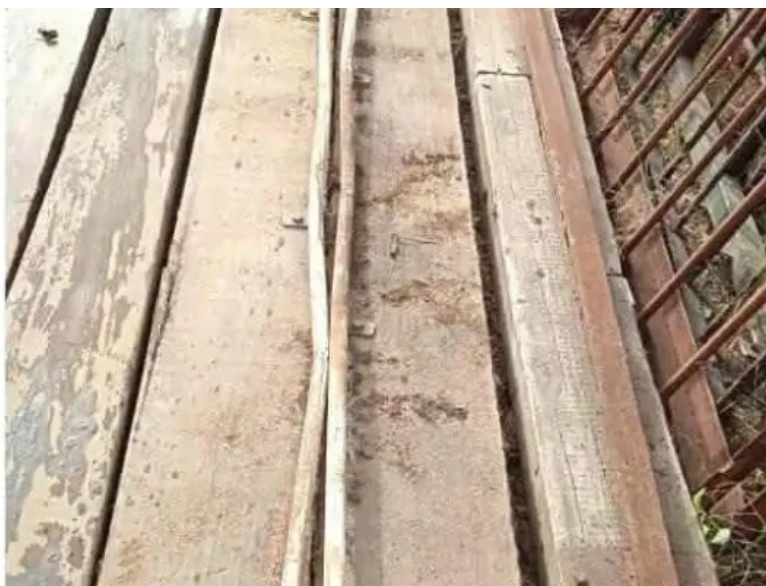
2 vigas de madera dura 13 03 2021
